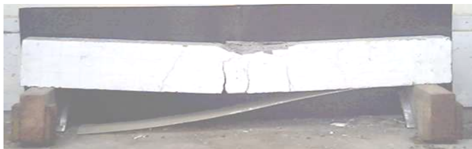
Gambar 9. Model Keruntuhan Balok Dengan Penambahan 2 lapis GFRP (GFRP Debonding)
