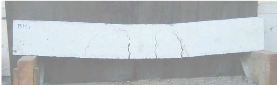
Gambar 7. Model Keruntuhan Balok Tanpa Penambahan Lapis GFRP
